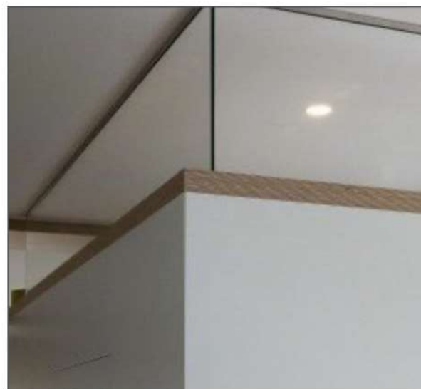
Détail lucarne. Bois en finition au dessus de la cloison
